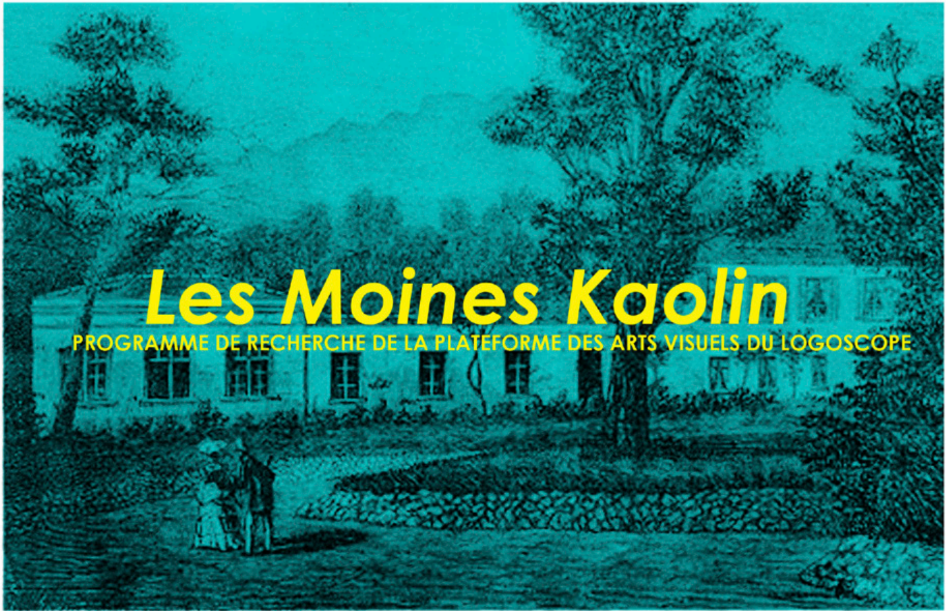
BÂTIMENT DE LA POTERIE ARTISTIQUE DE MONACO
